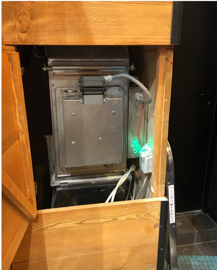
Die Fettabluftreinigung mit zwei purventus-UV-Filtern ist in der Fritteusenanlage integriert.
